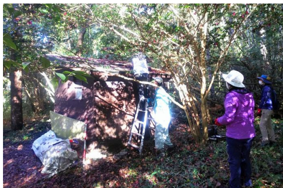
小屋屋根の清掃
