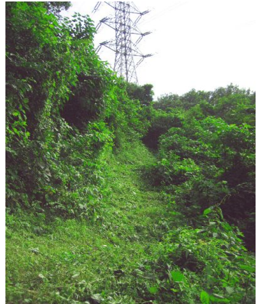
鉄塔 No36 付近
